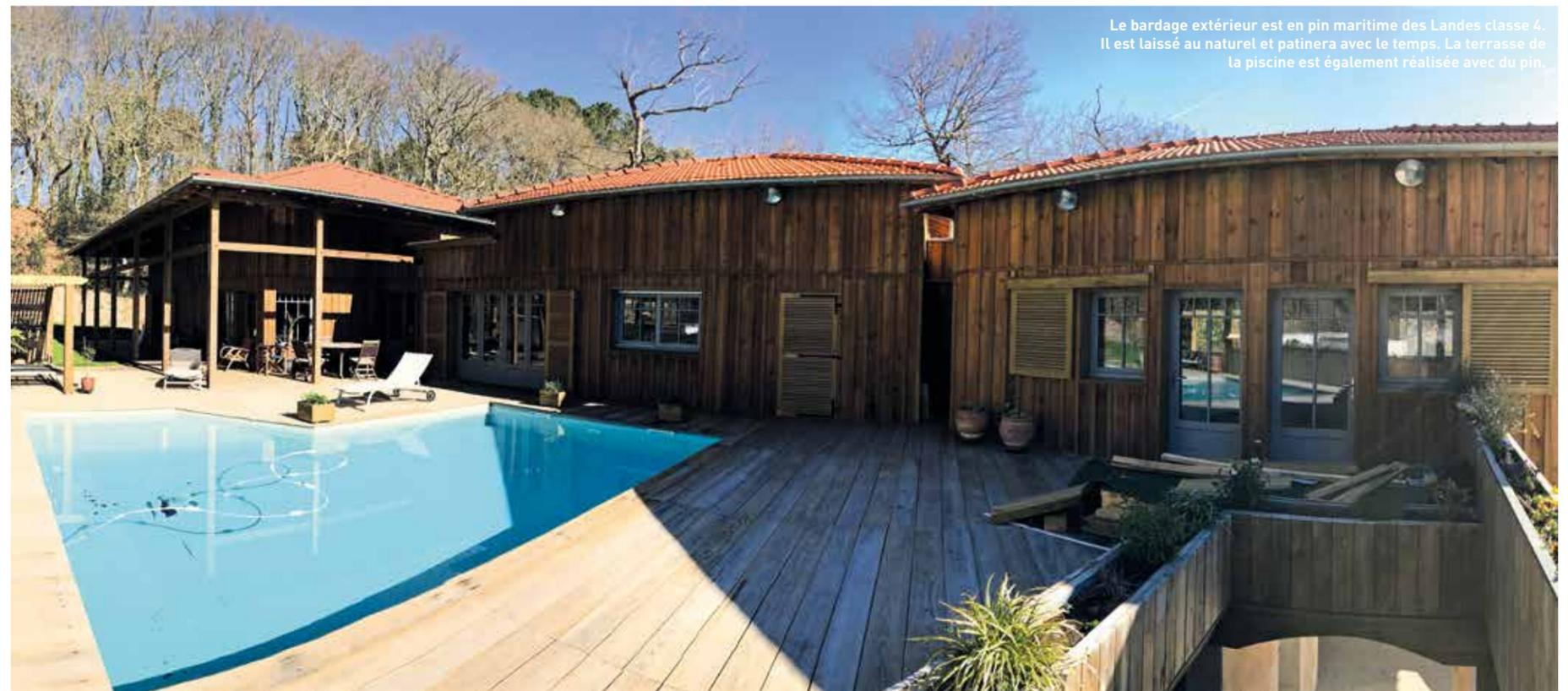
Le bardage extérieur est en pin maritime des Landes classe 4. Il est laissé au naturel et patinera avec le temps. La terrasse de la piscine est également réalisée avec du pin.
