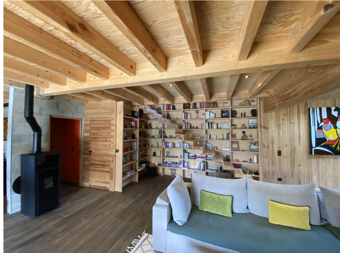
Plancher sur solivage apparent
